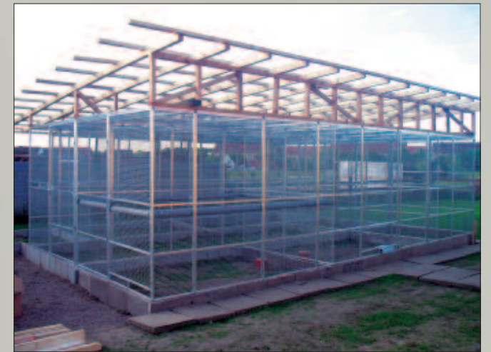
Der oberirdische Teil der Anlage mit der noch unfertigen Dachkonstruktion Foto: V. Lauterbach
