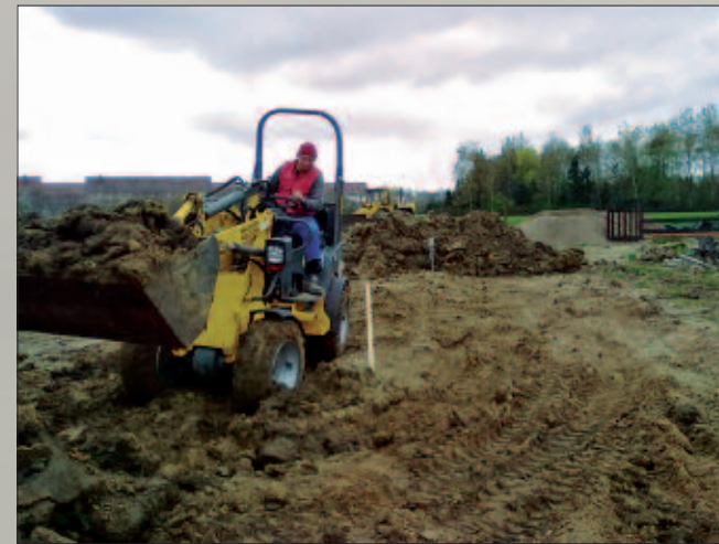
Ein großes Bauprojekt erfordert schweres Gerät Foto: V. Lauterbach
